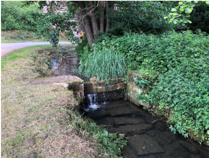
Foto 19: Querbauwerk ohne Grunddurchlass bei Penzenhof, zur Ableitung von Wasser für Fischteiche
