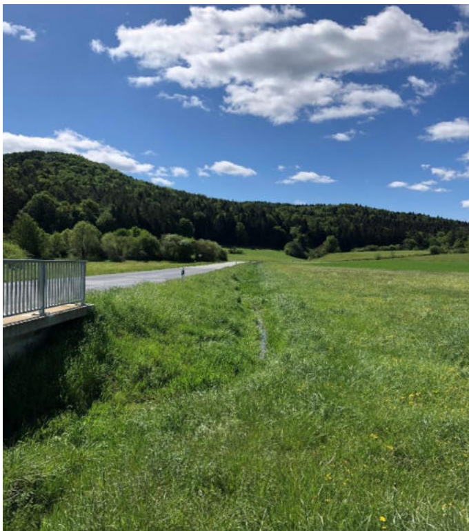
Foto 16: Blick in Richtung Etzelwang, Einmündung Kirchenreinbach / Gemeindeverbindungsstraße AS 39
