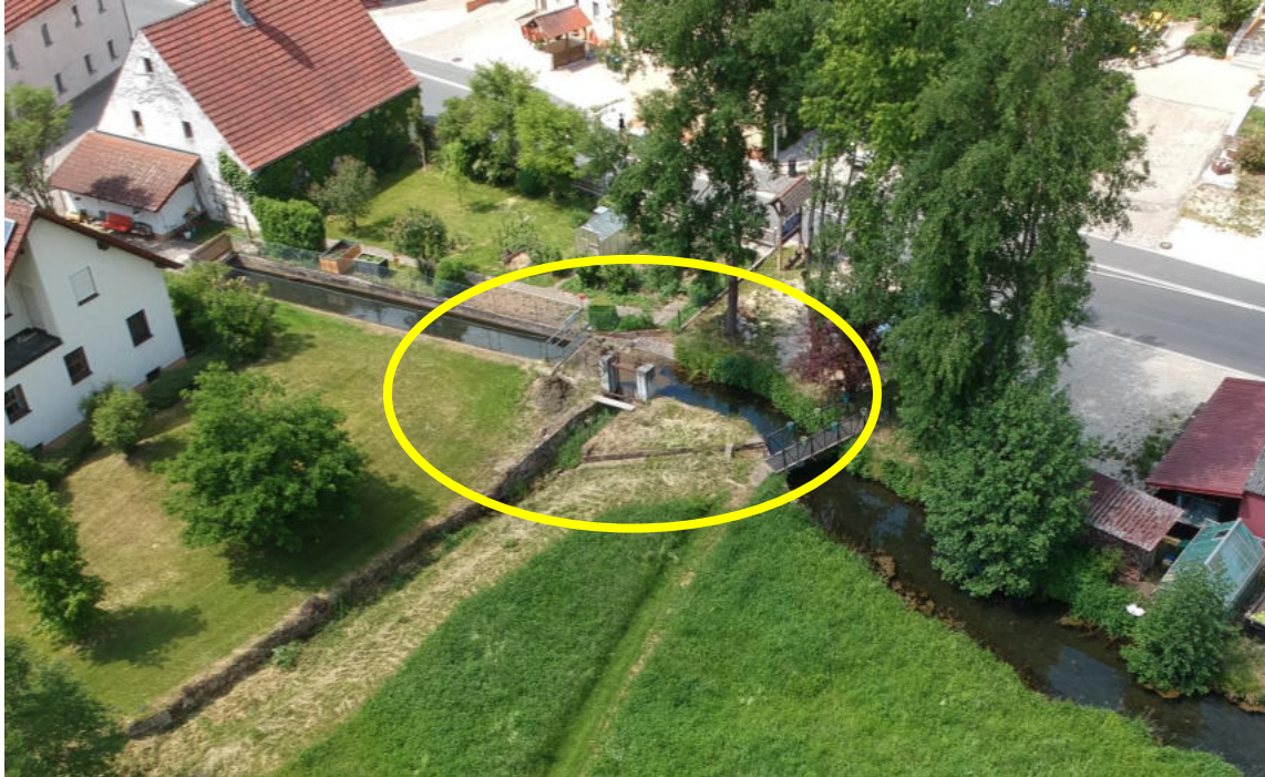
Foto 8: Vollständige Ableitung des Etzelbachs in den Mühlkanal bei Lehendorf
