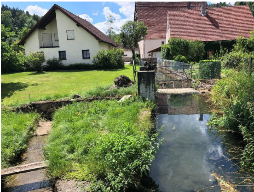
Foto 15: Stauanlage am Etzelbach
