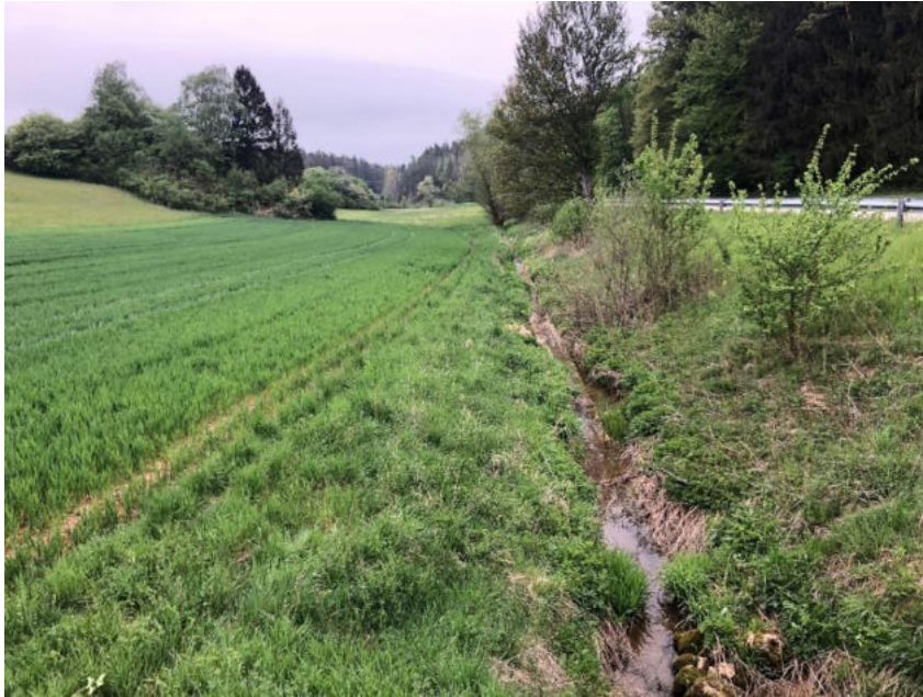
Foto 1: Reinbach zwischen Gaisheim und Kirchenreinbach – Überblick über den befestigten Abschnitt
