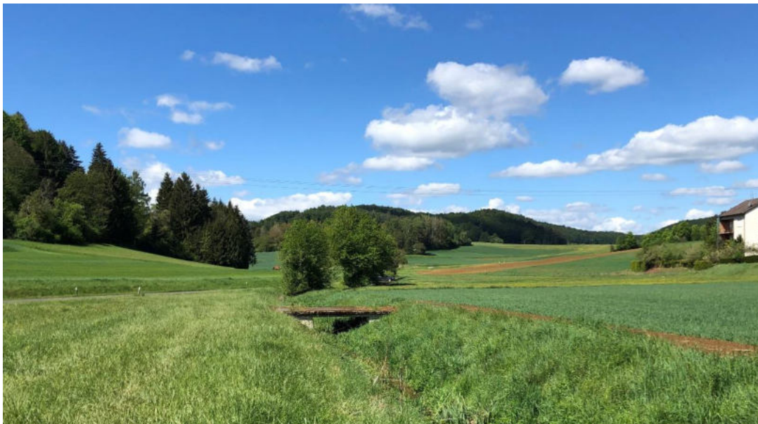
Foto 3: Beispiel für einen Plattendurchlass westlich von Kirchenreinbach (Reinbach)
