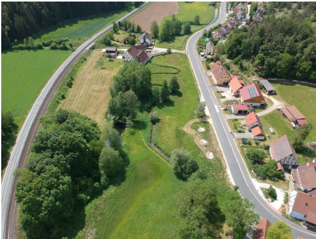
Foto 17: Naturnaher Auenbereich bei Penzenhof
