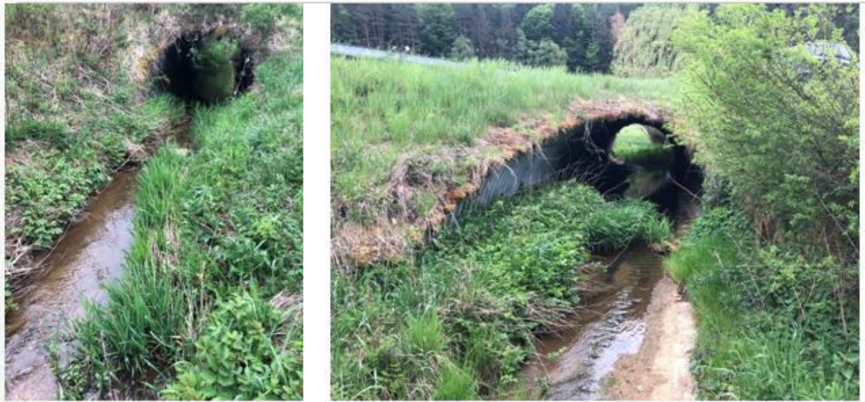
Foto 4: Rundrohrdurchlässe (500 mm, 1200 mm) mit unterschiedlichen Folgen für Durchgängigkeit und Strömung (Reinbach)
